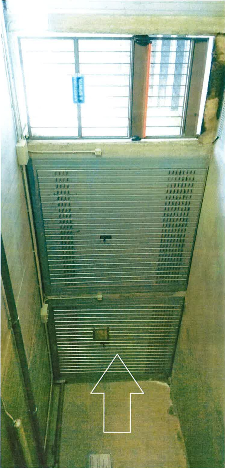
Box oggetto della perizia
