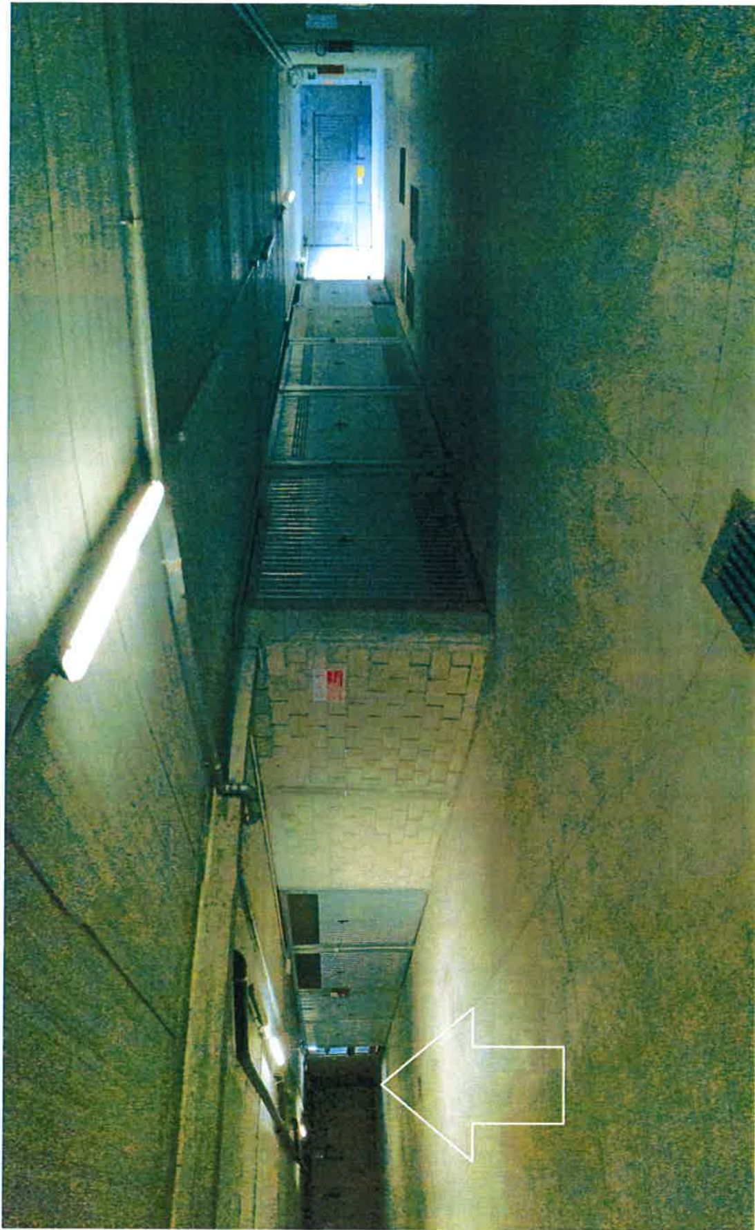
Box oggetto della perizia
