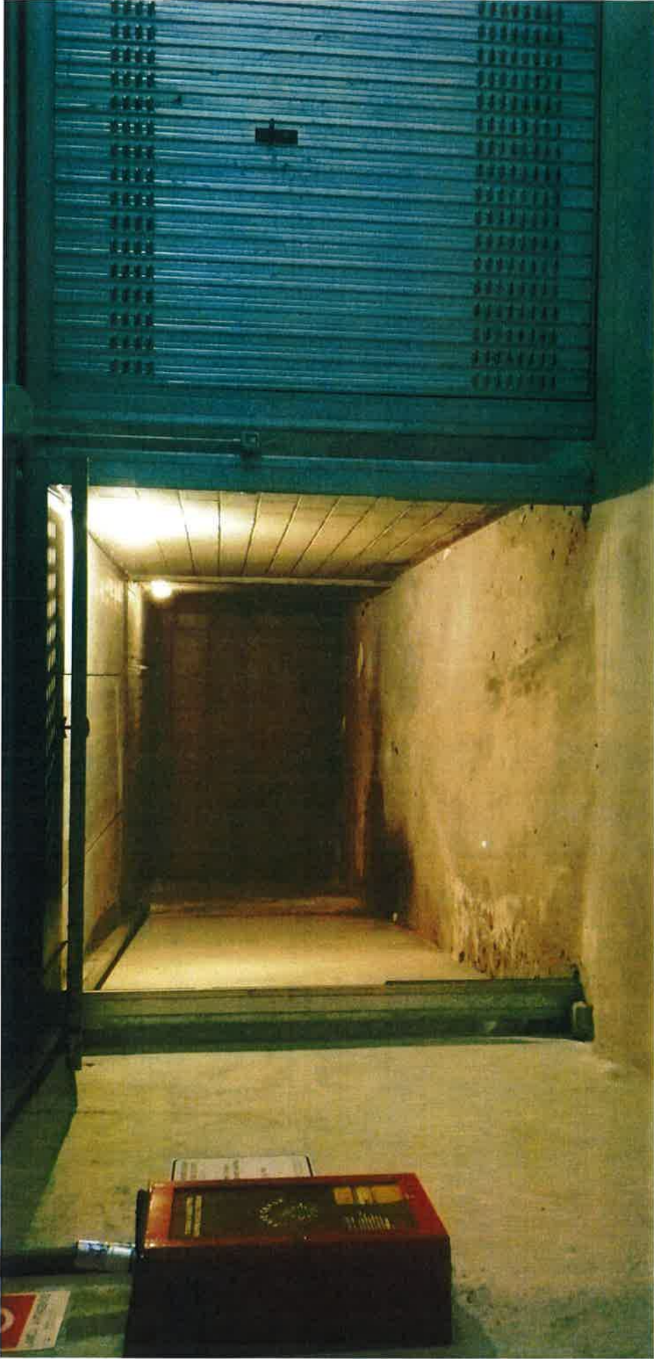
Box oggetto della perizia
