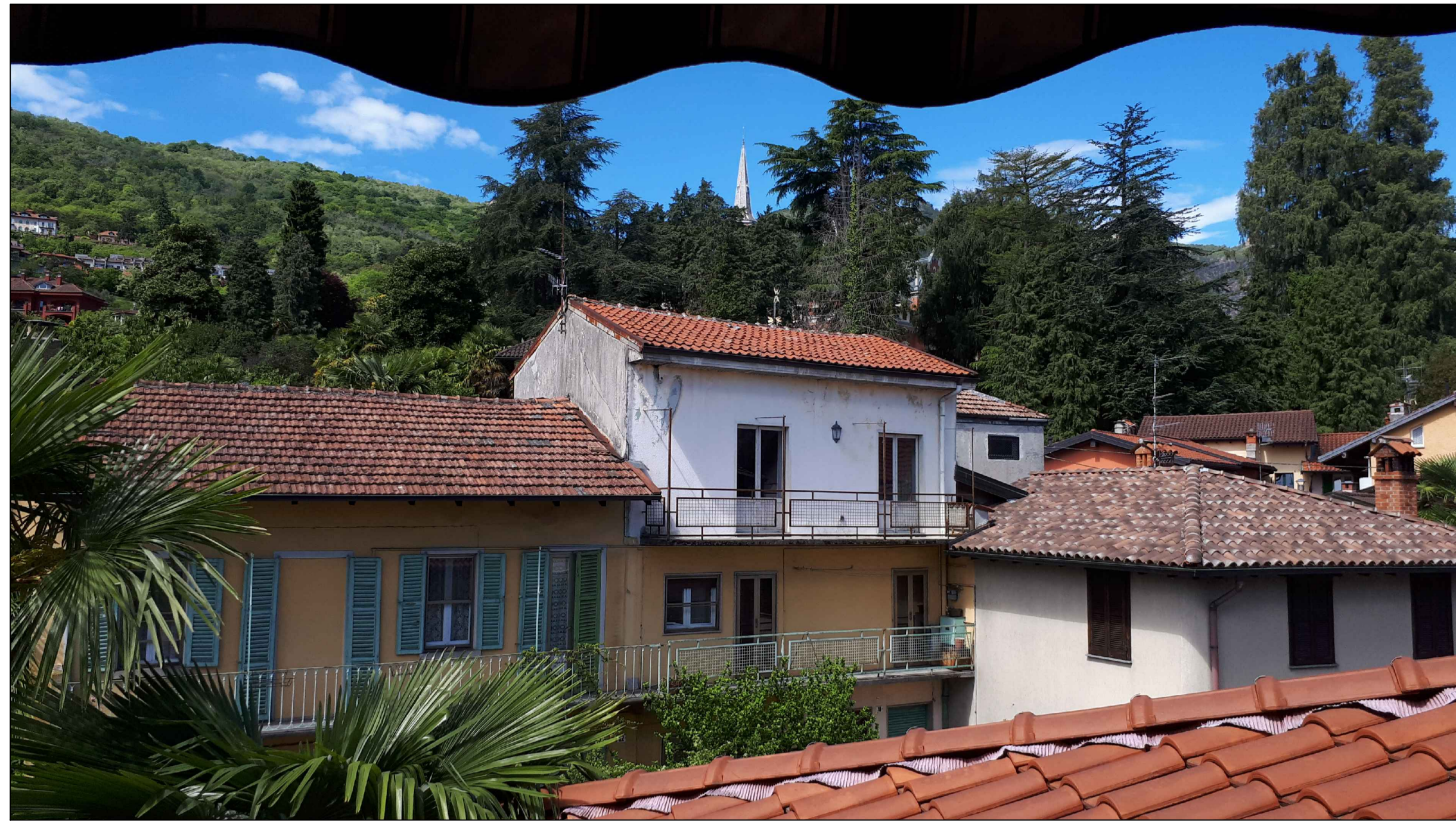
Tetto in Tegole Marsigliesi come esistente
