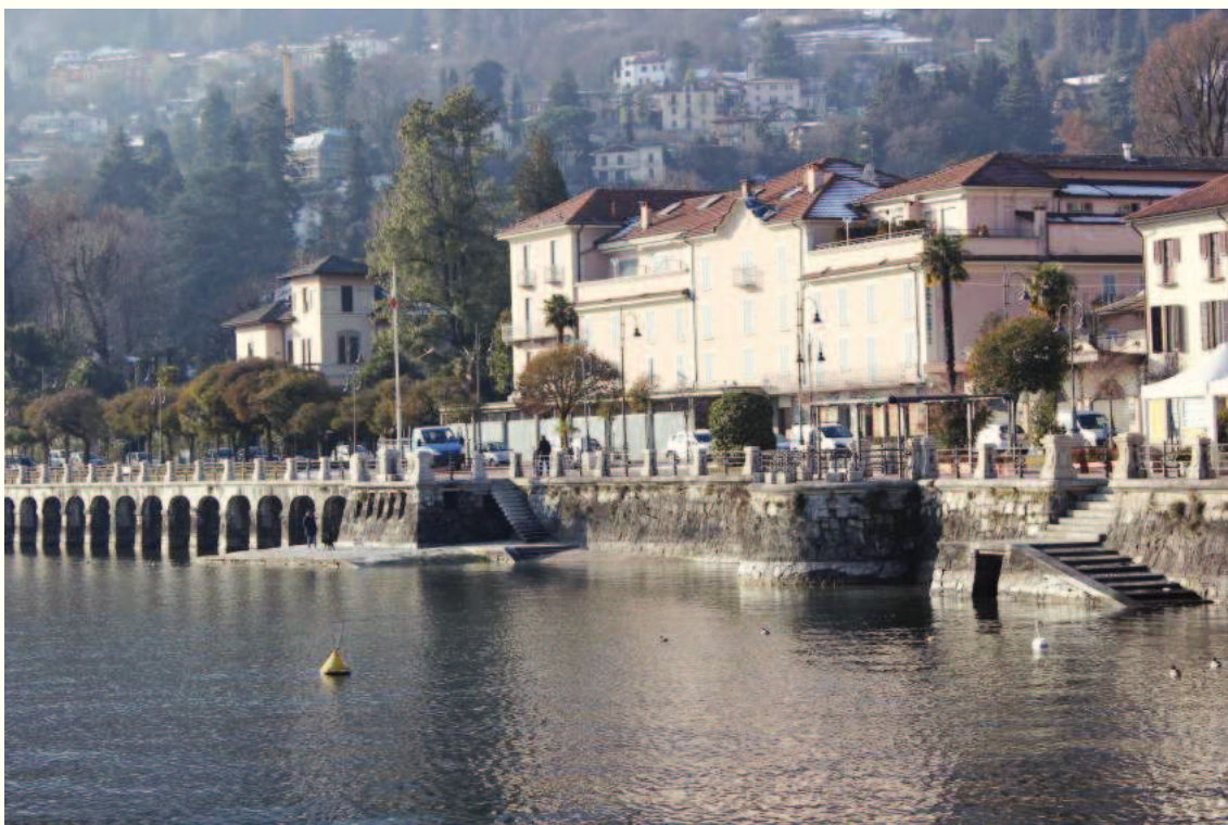
2 VISTA DEL LUNGOLAGO. Vista in primo piano della struttura di copertura del dehors dell'albergo Eden realizzato con profili sottili in ferro, tenda piatta impacchettabile colore ecru
