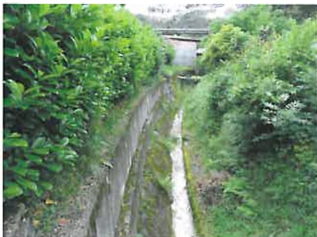
*Foto 4 – Pavimentazione e muri d'argine in cls*
